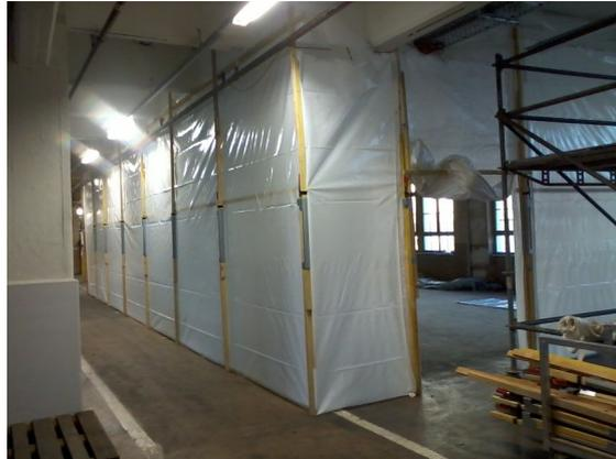
Robuste Baustellenabtrennung bei einer Parkhaussanierung mit Hölzern 40 x 60 beplankt mit Seekieferplatten 15 mm Stärke.
