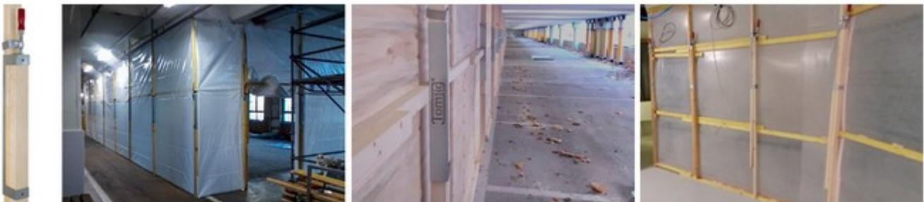
Schnellspannvorrichtung Tomjig für Staubschutzwände mit Dachlatten 30/50mm oder 40/60mm
