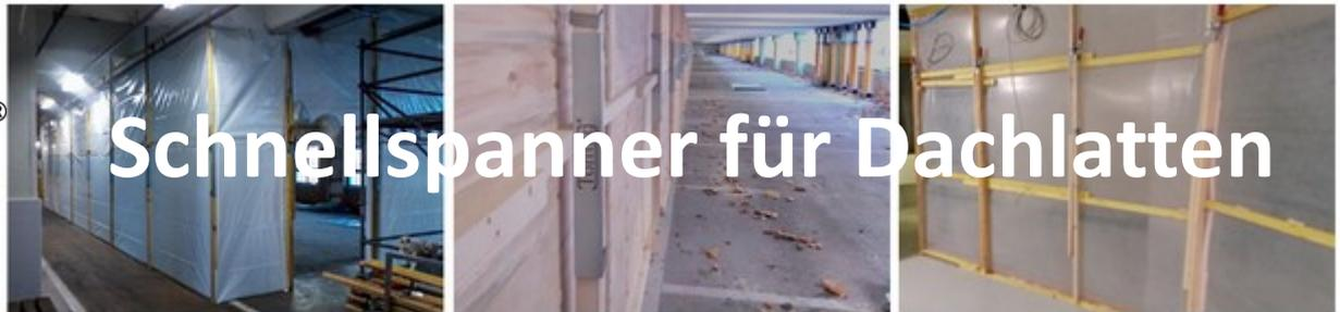
Schnellspannvorrichtung Tomjig für Staubschutzwände mit Dachlatten 30/50mm oder 40/60mm
